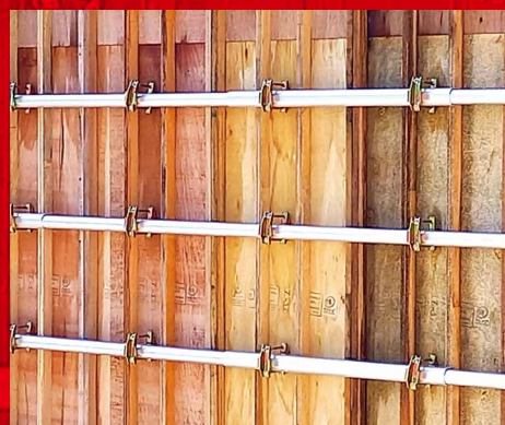
型枠一本締め工法
