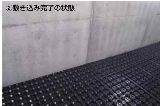
湧水パネルを外壁面に合わせて敷き込んでいきます。敷き込みの終端、配管位置、柱部分など、基本サイズで敷き込めない部分は、ハンドカッター等で湧水パネルを切断加工して対応します。また、外壁面等の端部は市販のガムテープで、ノロ止め処理を行ってください。
