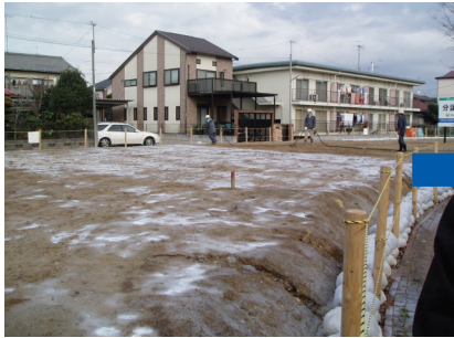
施工直後の状態
