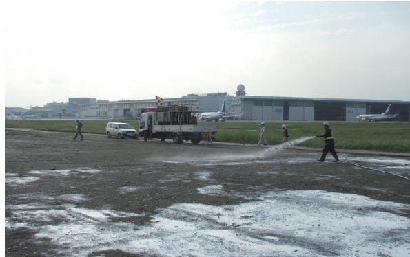
ハイドロシーダーによる施工状況
