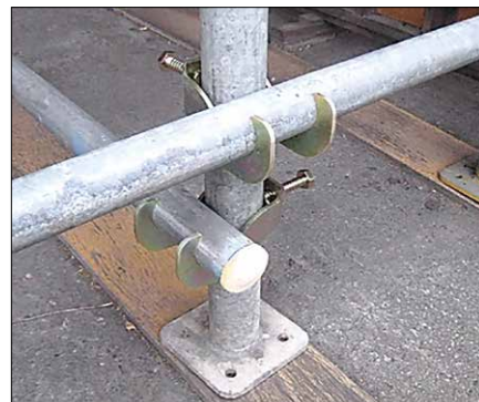
パイプサポート式 型枠支保工の根がらみ (写真はコネクトクランプ P)
