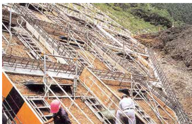
法面現場設置
