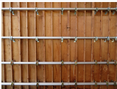
【型枠一本締め工法】
