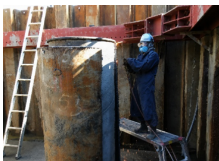
＜杭頭の鋼管溶断・コンクリートはつき状況＞
