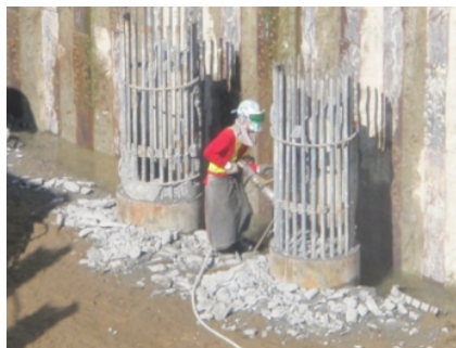
＜杭頭の鋼管溶断・コンクリートはつき状況＞
