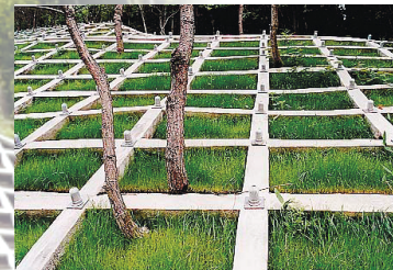
フリーフレーム工法
