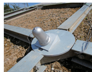
地山補強材施工例
