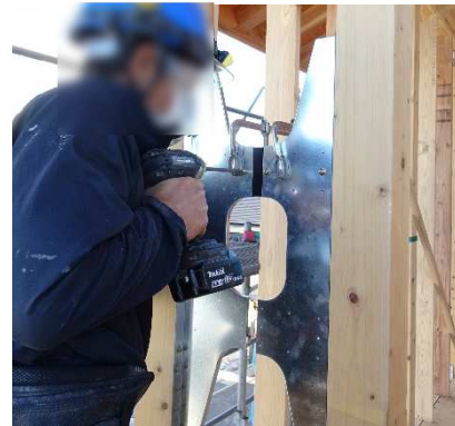
(e) HT 中間部材 (OKD-19)施工
