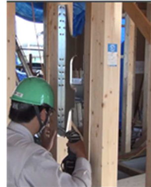
(c) CR2 プレート(OK-65)施工
