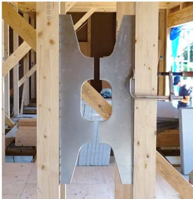
(d) CR2 プレート 2枚目施工
