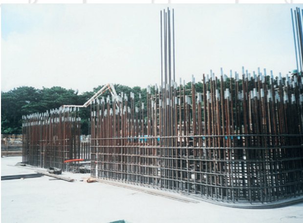
発電所の煙突工事（Ⅰ型）
