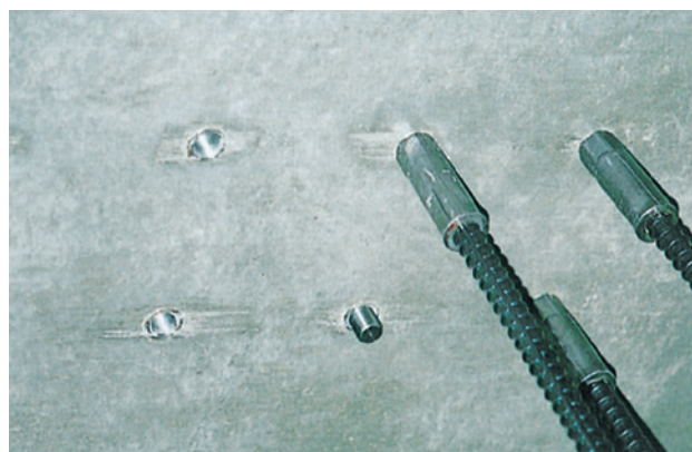
鉄筋取付状況
