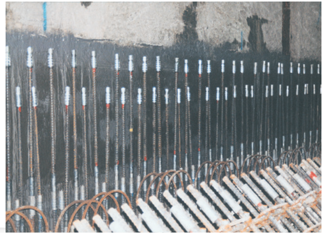
地下鉄壁主筋（Ⅱ型）
