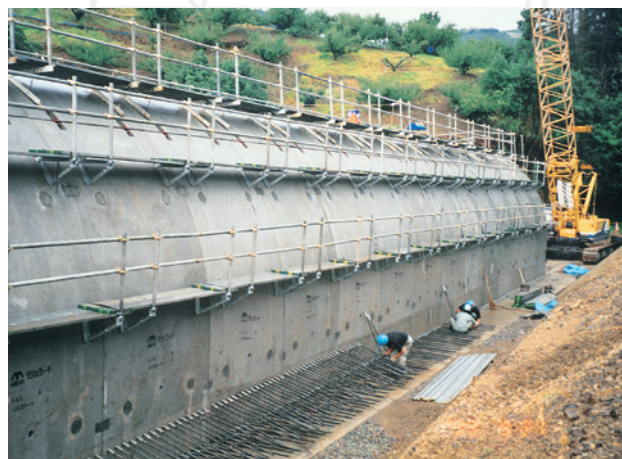
トンネル後打ちスラブ接合（Ⅰ型）
