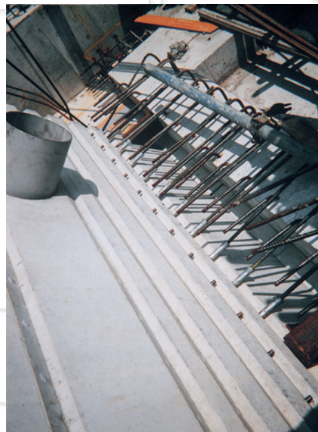
PC 部材との取り付け部（Ⅰ型）
