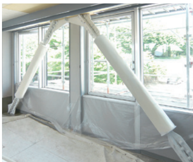
既存建物S造 事務所
