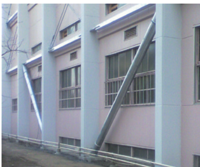
既存建物S造 教育施設
