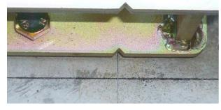
BS2柱脚金物をM12ボルトにより、高さを調整します。 水平器を使ってホゾパイプの垂直度を確認します。
