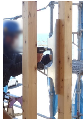
(c) CR2 プレート(OK-65)施工
