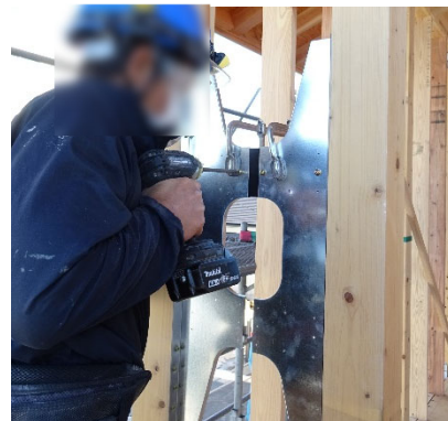
(e) HT 中間部材 (OKD-19)施工
