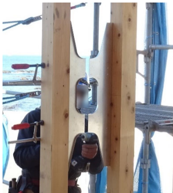
(d) CR2 プレート 2 枚目施工
