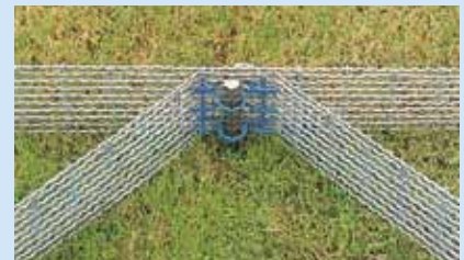
2 枚用ジョイント金具使用部 (天端・端部)
