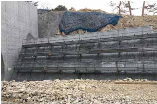
○のり面工事における足場システムで、施工の進捗に応じて容易に足場の組立ができ、下段の作業床より手摺りが取付けできるため安全の確保と施工生の向上が図れます。 **P46**
