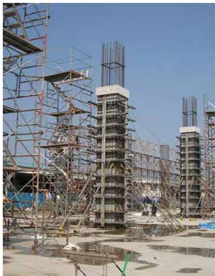
○柱型枠締付金具で、システム化することにより工事の合理化が図れます。
