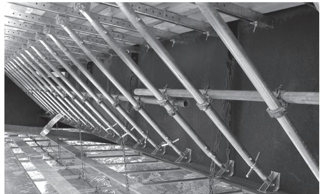
○橋梁及び高架道路の跳ね出し部分の床板工事に使用します。
