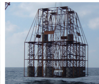
AS魚礁 15M型 (貝殻入り) 高15.0×幅11.1×長11.1m 重量51.4t 空容積1530.3m 3
