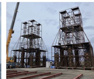
AS魚礁 21M型 (木材入り) 高21.0×幅12.0×長12.0m 重量97.1t 空容積2029.4m 3
