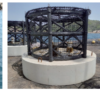
MF礁 2.1M型 (全防護籠) 高2.2×幅3.0×長3.0m 重量10.1t ステム: 3本 海藻種苗移植: 13箇所
