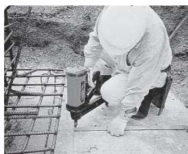
①PF下ランナー コンクリート釘止め
