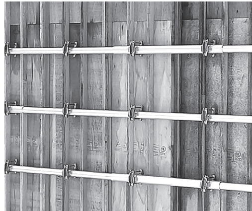
型枠一本締め工法
