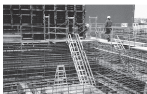
ケーソン階段設置
