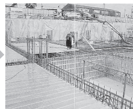
⑧PF上ランナー取付、ビス止め ⑨フラットデッキ敷込・ビス止め
