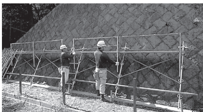
③伸縮手すり設置
