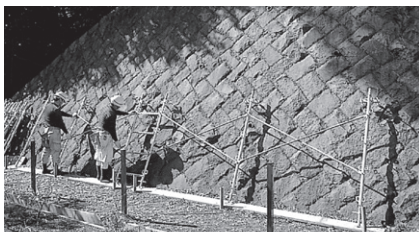
①のり支柱設置
