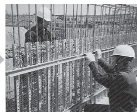
④PFバタ取付・PEナット締付
