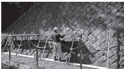
②鋼製布板設置
