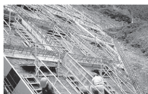
法面現場設置
