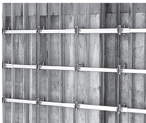
型枠一本締め工法
