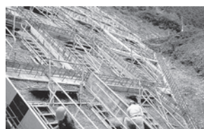
法面現場設置
