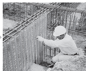
②パンチングフォーム準備（パネル連結、曲げ加工等） ③パンチングフォーム配置
