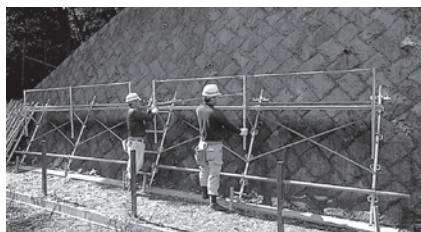
③伸縮手すり設置
