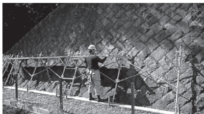
②鋼製布板設置
