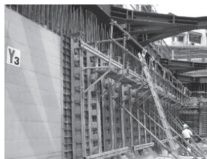
免震構造地下擁壁
