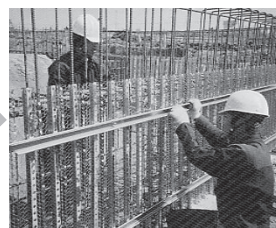
④PFバタ取付・PEナット締付
