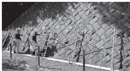
①のり支柱設置
