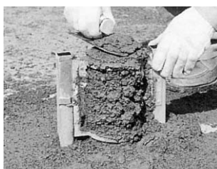
③ 吹き込み後、ネットモールドからはみ出した部分を除去・整形します。
