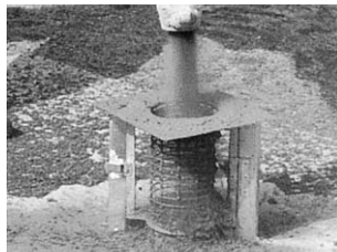
② ネットモールドにモルタル・コンクリートを吹き込みます。
