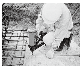
①PF下撑条 混凝土固定钉
