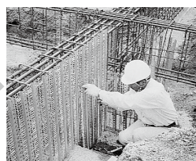
②准备地下模板（板连接、弯曲加工等） ③配置地下模板
