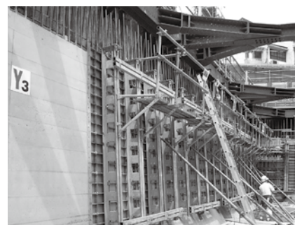
防震结构地下护墙
