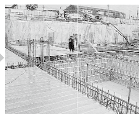
⑧安装PF上撑条，用螺丝固定 ⑨铺设平板、用螺丝固定
