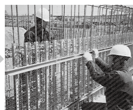
④安装PF补强材料、紧固PR螺母
